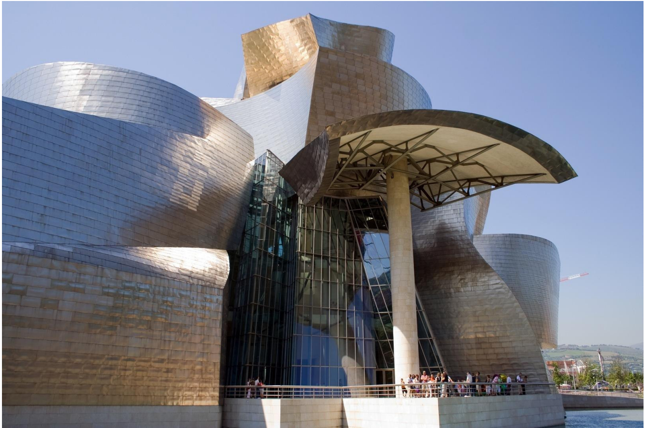
Figura 3 : Museo Guggenheim, Bilbao (1997), dettaglio
